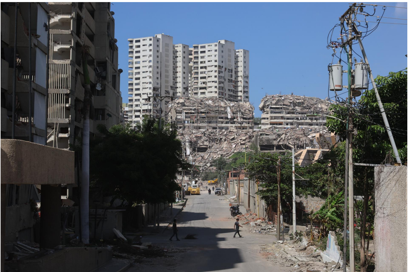
Fotografía que muestra escombros de edificios afectados por el doble terremoto de magnitudes 7,2 y 7,5, este miércoles, en La Guaira (Venezuela). EFE/ Miguel Gutiérrez
