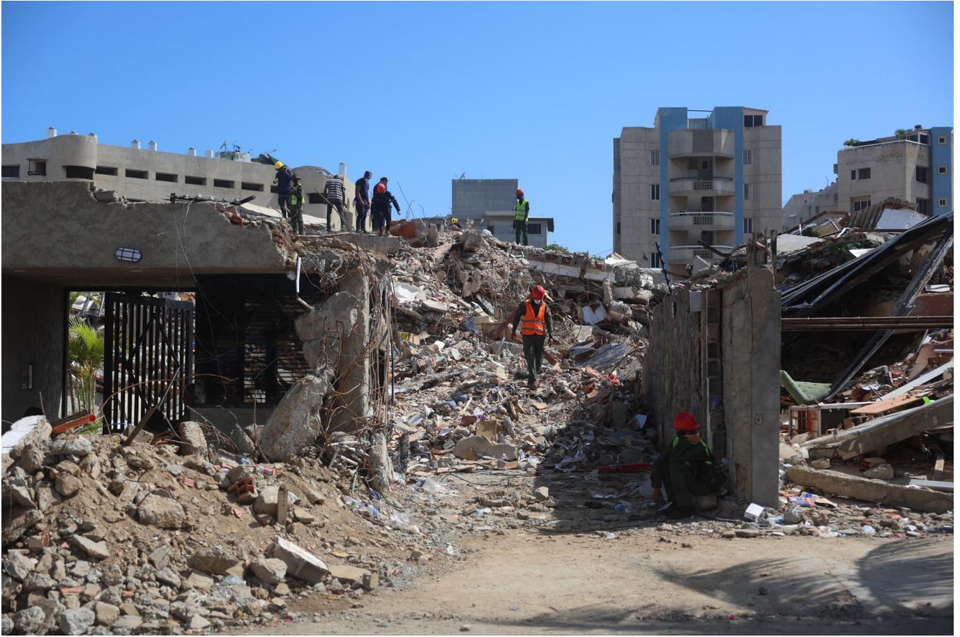
Fotografía que muestra escombros de un edificio afectado por el doble terremoto de magnitudes 7,2 y 7,5, este miércoles, en La Guaira (Venezuela). EFE/ Miguel Gutiérrez
