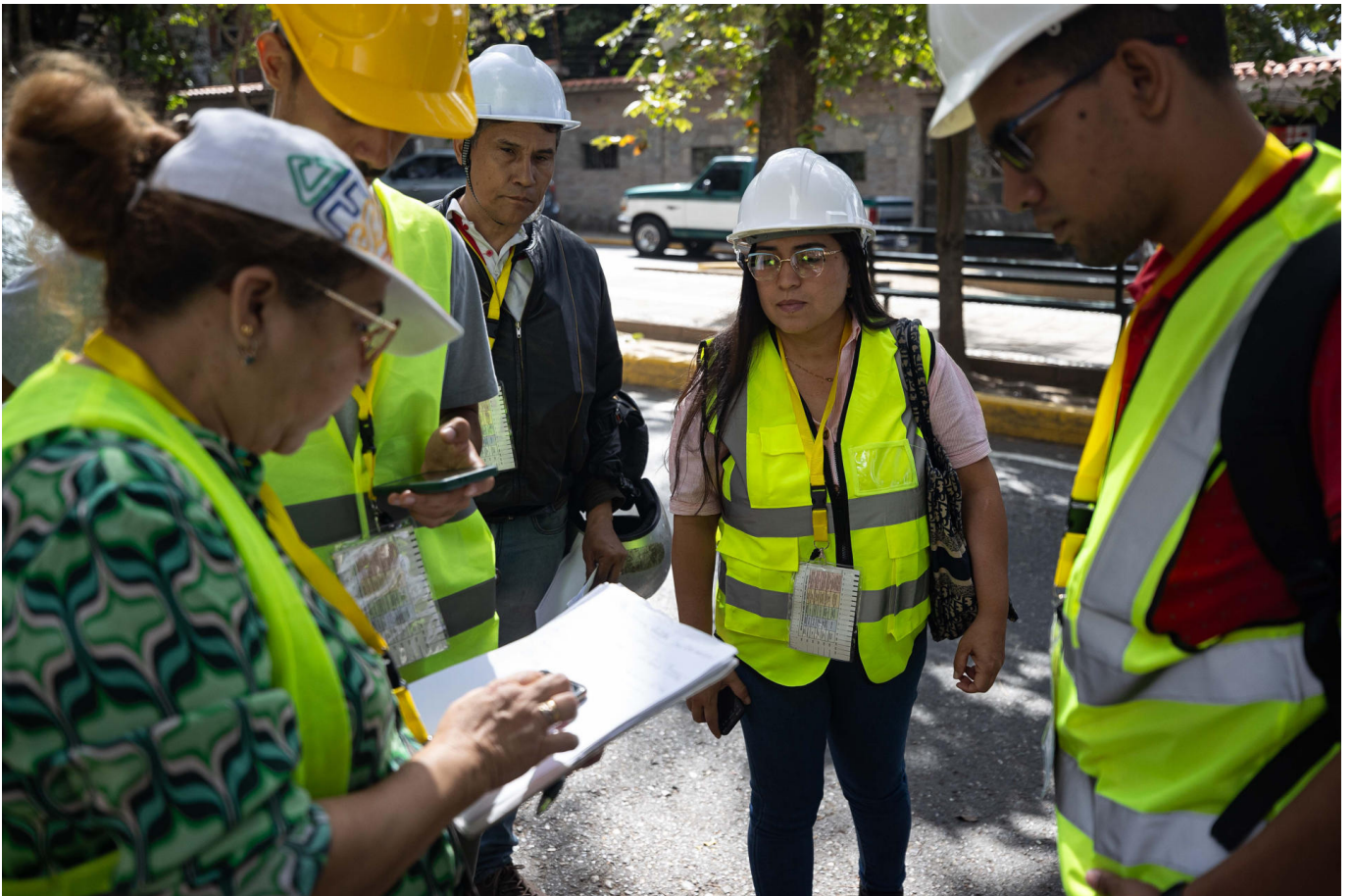
AME349. CARACAS (VENEZUELA), 18/07/2026.- Fotografía del 15 de julio de 2026 que muestra a la ingeniera Betzi Gutiérrez (c) realizando una inspección en un edificio afectado por los dos terremotos en Caracas (Venezuela). Cuando Betzi Gutiérrez se calza sus botas y viste su chaleco amarillo y casco blanco de ingeniera para revisar las bases de los edificios afectados por el doble terremoto, ocurrido en la zona norte de Venezuela, no solo carga con las herramientas y la responsabilidad de su profesión; también lleva el peso de haber visto su propio techo desplomado el pasado 24 de junio. EFE/ Ronald Peña R
