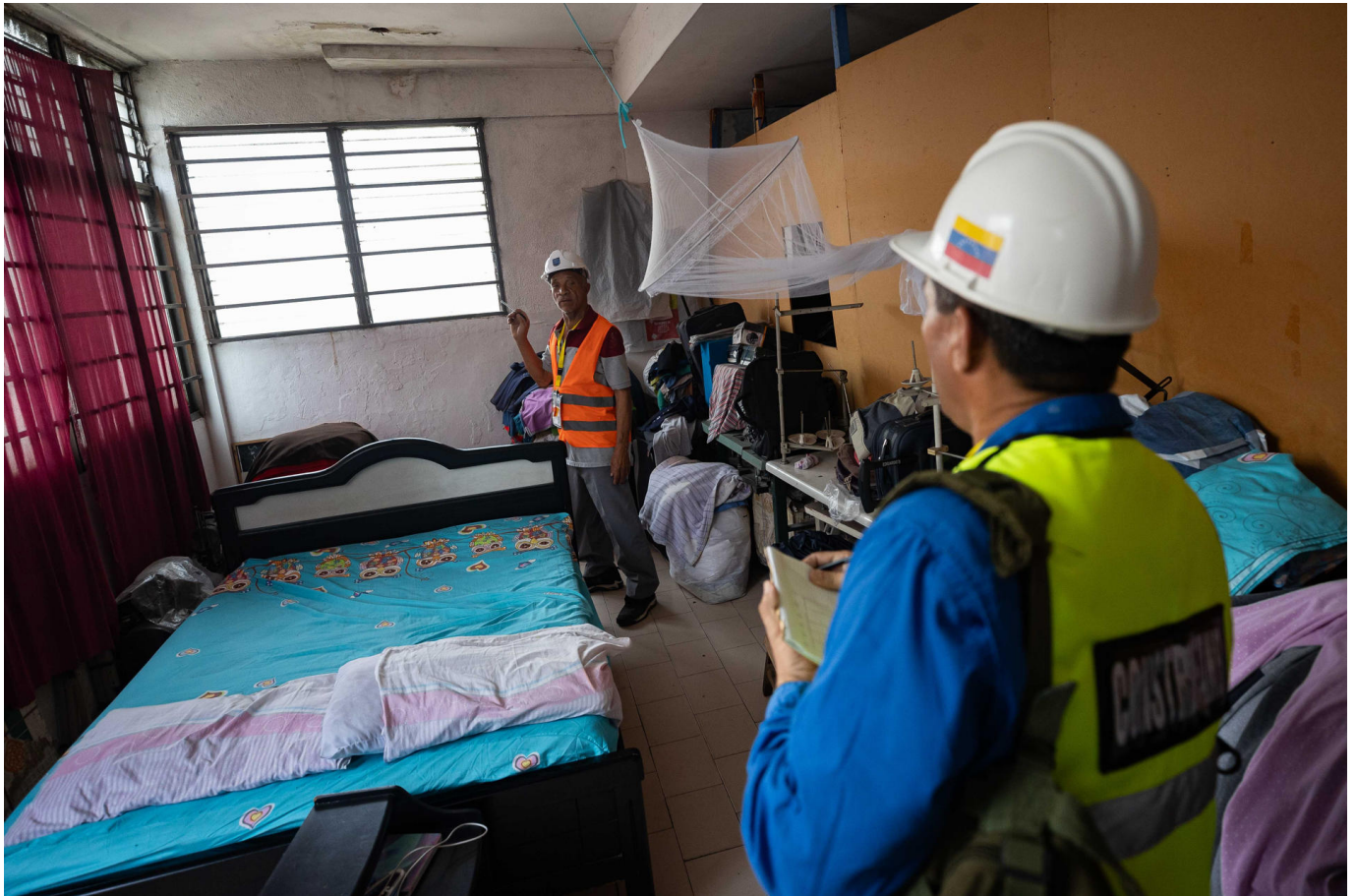
AME343. CARACAS (VENEZUELA), 18/07/2026.- Fotografía del 14 de julio del 2026 que muestra a ingenieros inspeccionando un edificio afectado por los dos terremotos en Caracas (Venezuela).
