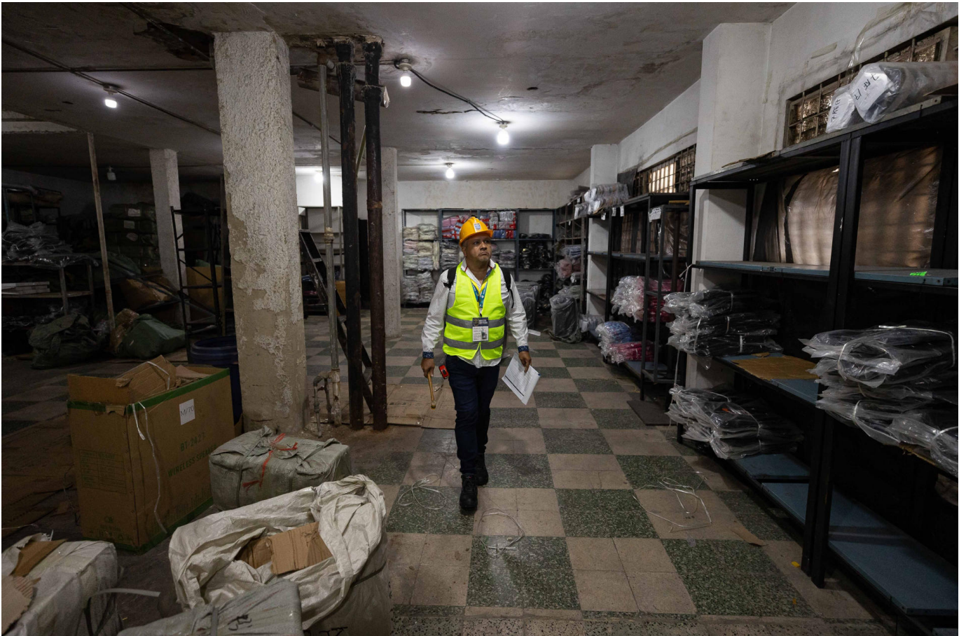
AME341. CARACAS (VENEZUELA), 18/07/2026.- Fotografía del 14 de julio de 2026 que muestra a un ingeniero inspeccionando un edificio afectado por los dos terremotos en Caracas (Venezuela).
