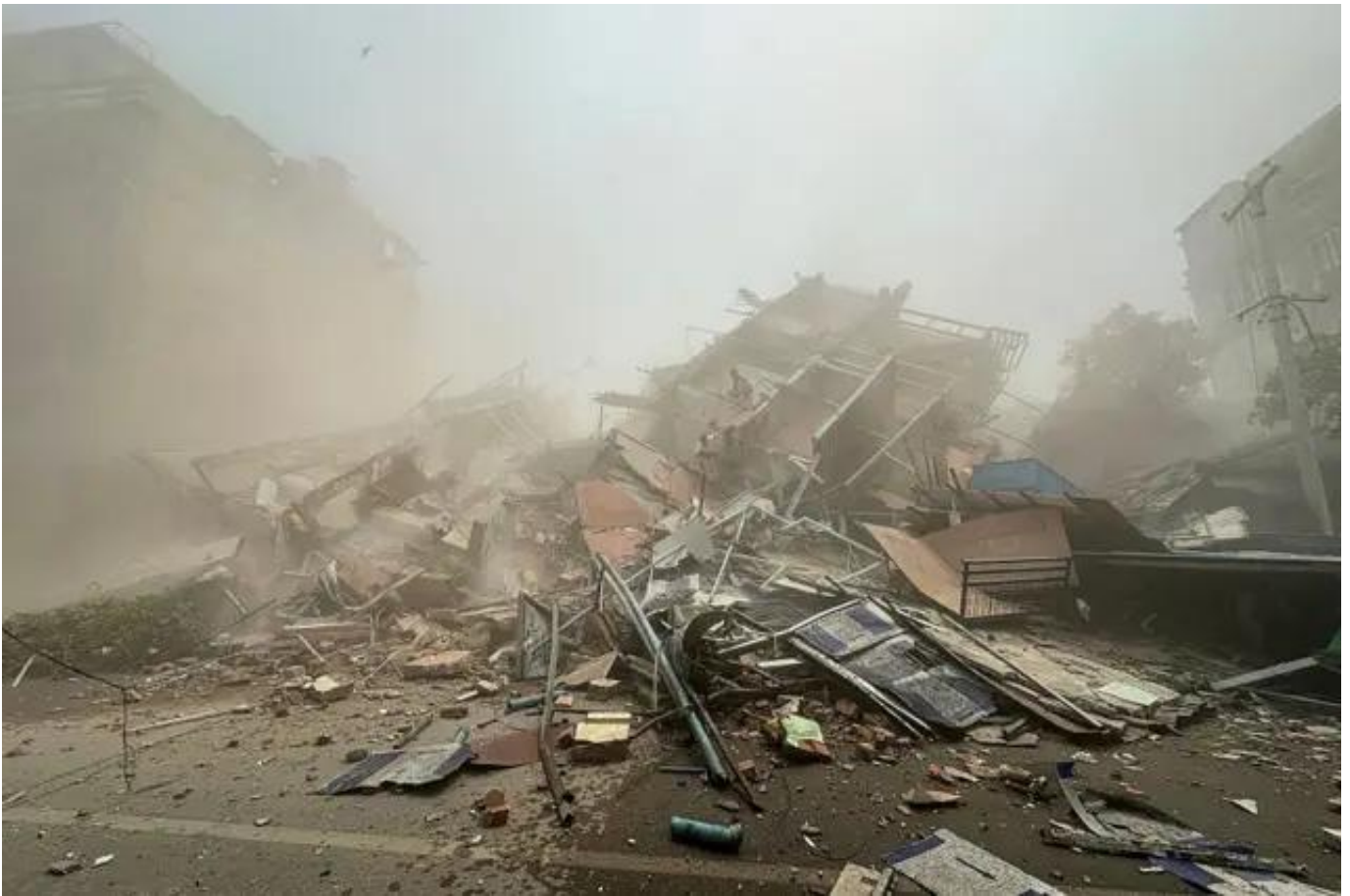
Escombros de un edificio derrumbado en Myanmar.
