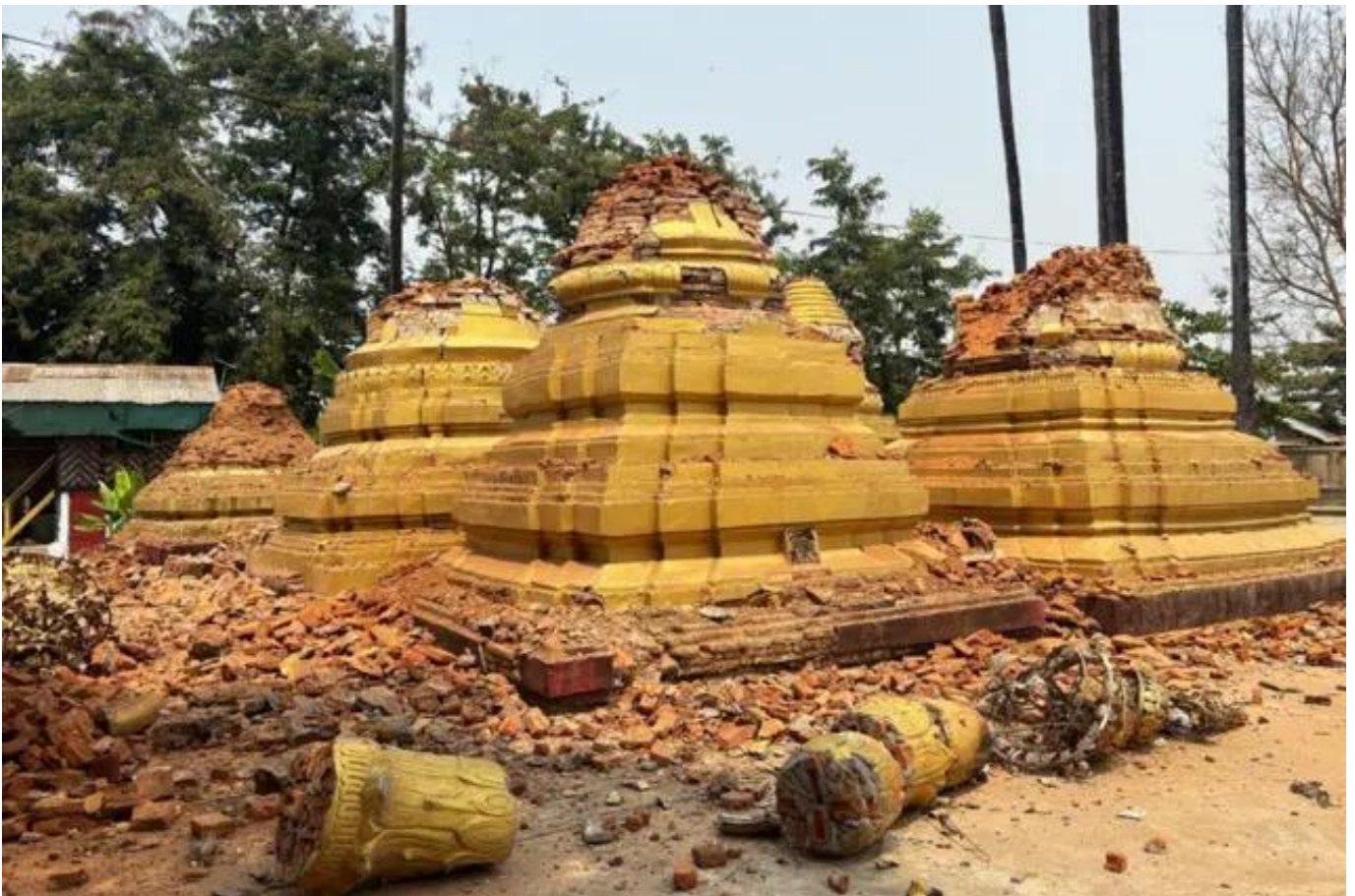
Se ven pagodas dañadas en la capital de Myanmar, Naipyidó.
